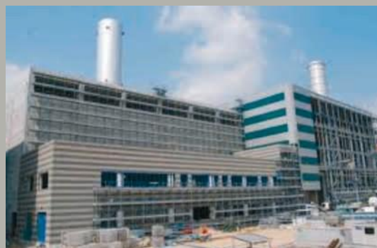
Torino - Centrale telerisc. - Impresa Adanti
